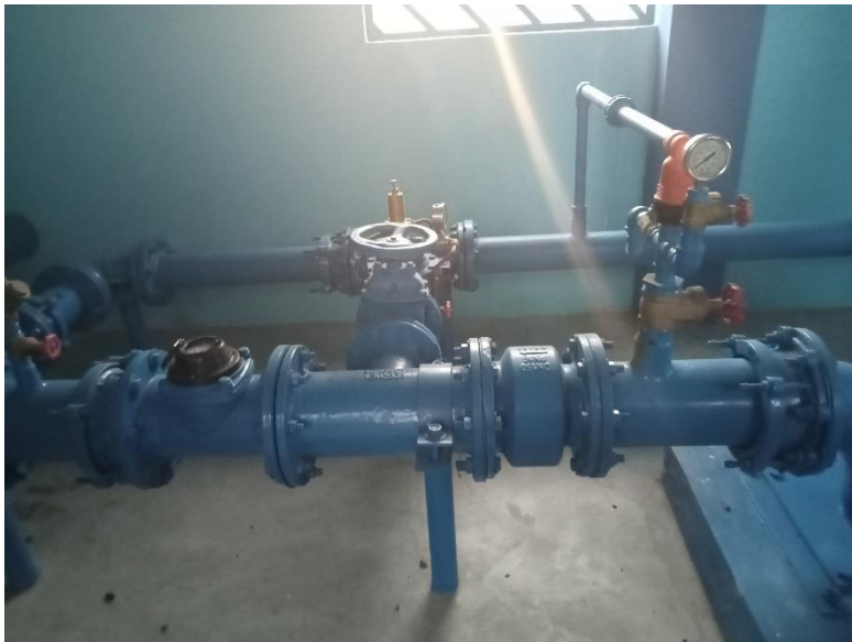
Imagen N° 17: Caseta de bombeo del pozo del CP Cambio Puente
