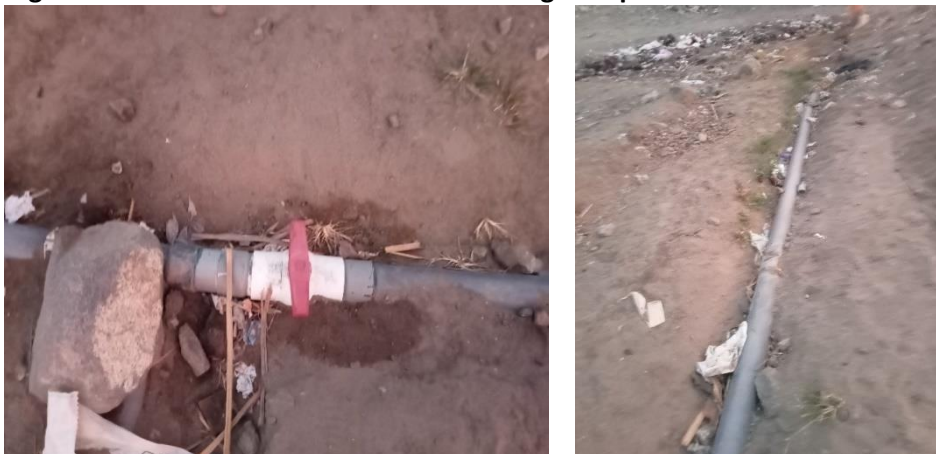
Imagen N° 18: Vista de tramos de la línea de agua expuesta en CP Cambio Puente
